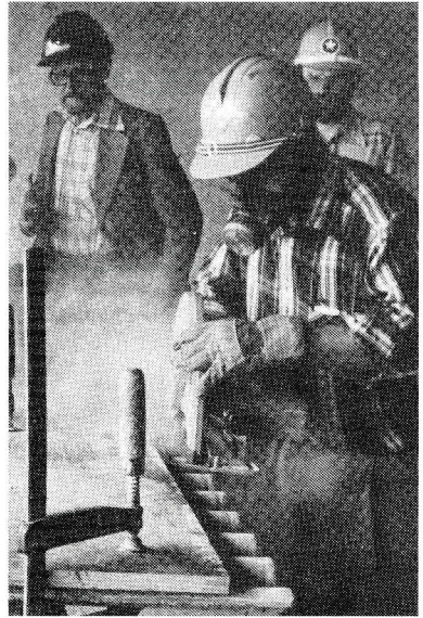
Uforvarlig skæring af asbestholdige eternitplader.
